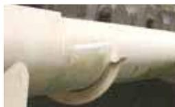
**Tissu enduit de résine époxy pour la réparation de fuites, fissures et trous sur surfaces rigides planes ou peu accessibles.**
